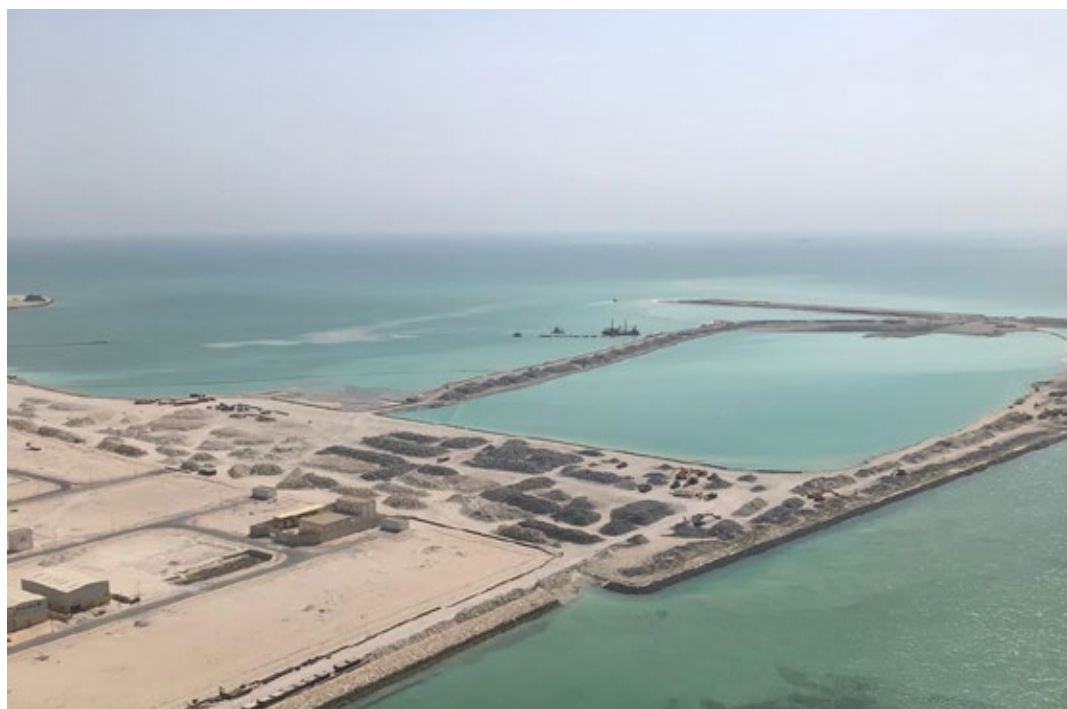
IGB - Phase 2 - site progress
